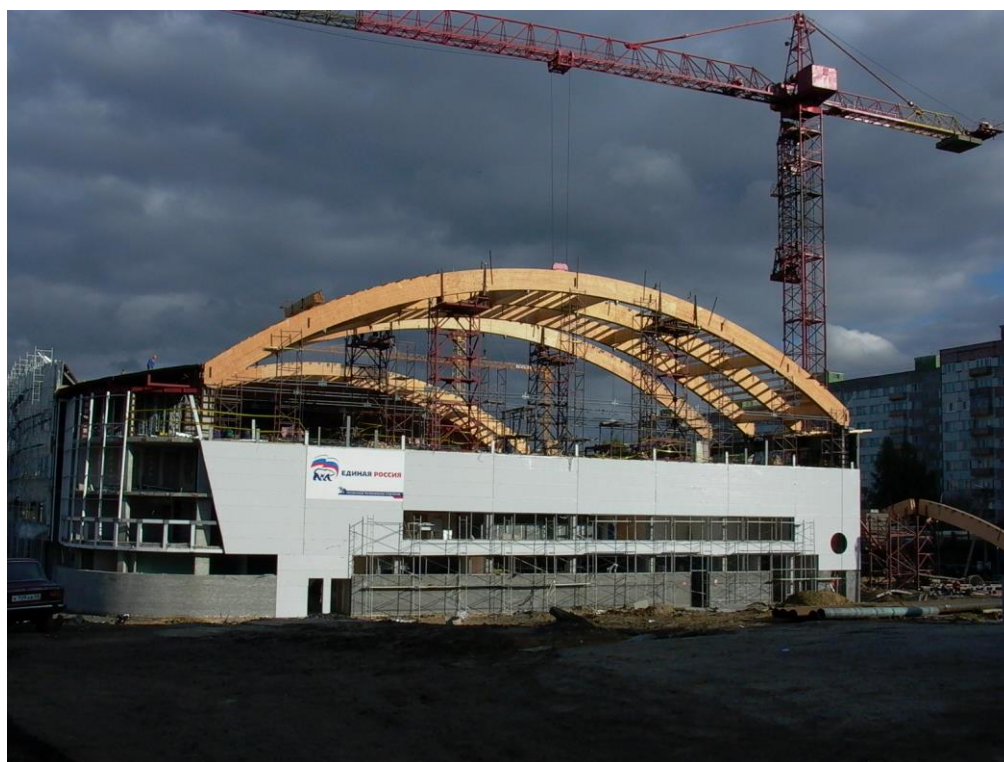
Рис. 15. Монтаж клеюдеревянных арок покрытия
