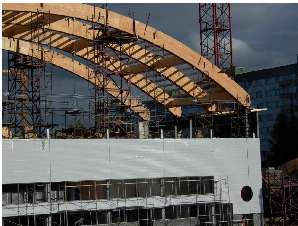
Рис. 12. Двухшарнирная клеедеревянная арка пролетом 48 м
